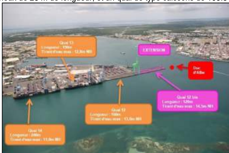
Terminal portuaire de Jarry (quais 14, 13 et 12)
